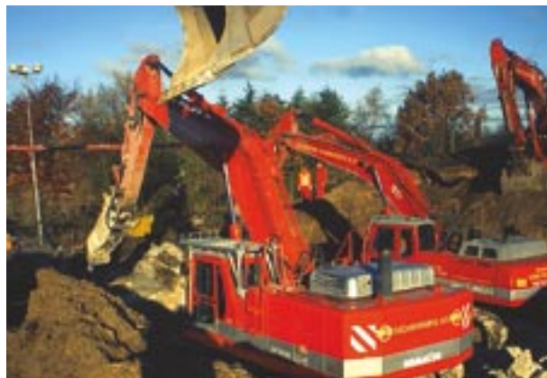
Der rådes over en komplet maskinpark til både nedbrydning, opbevaring, transport samt bortskaffelse
